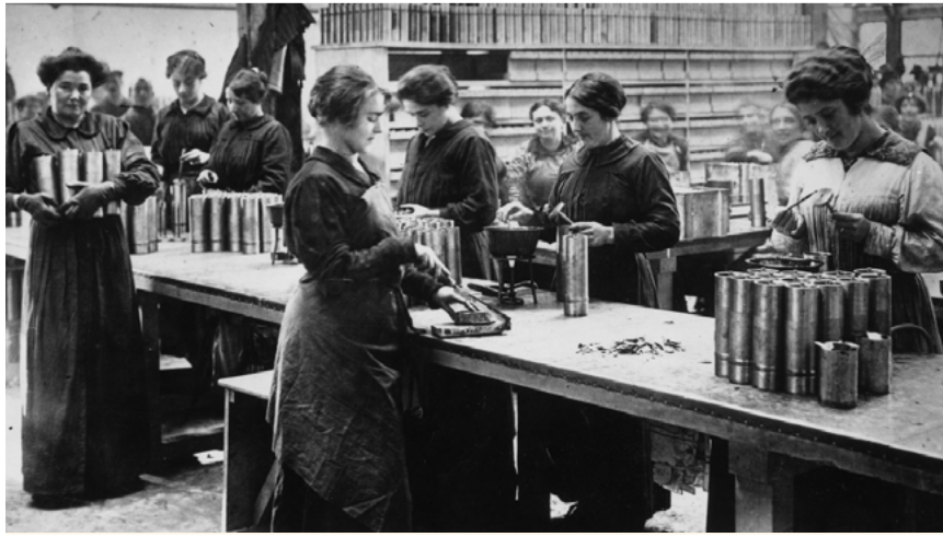
Obreras en una fábrica
